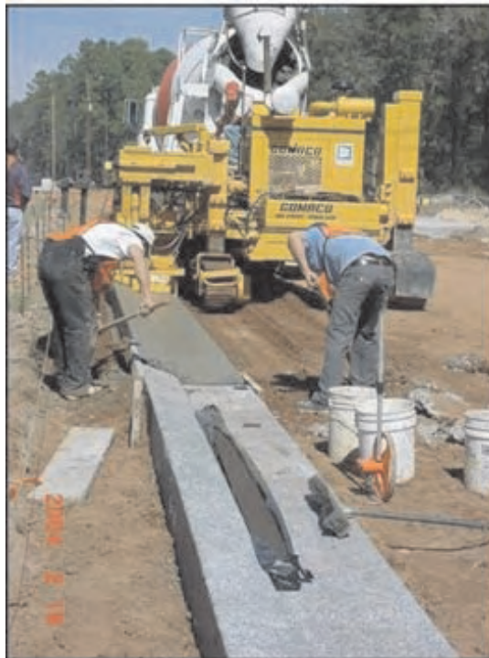
Слика 9.11 Машинска уградња ивичњака са риголом
