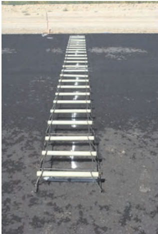
Слика 4.33 Распоред анкера и можданика пре бетонирања
