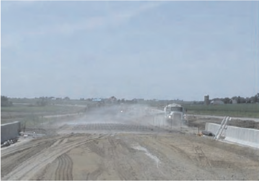
Слика 4.32 Пре бетонирања треба положити фолију или попрскати подлогу да не би дошло до појаве пукотина у бетону
