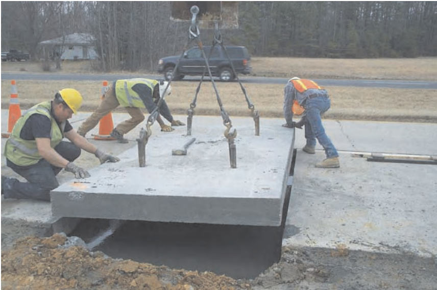
Слика 7.75 Полагање префабриковане бетонске плоче
