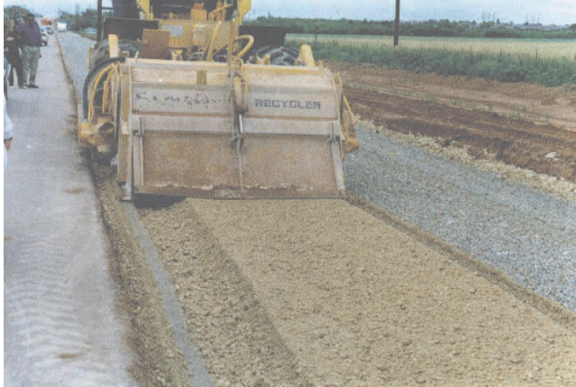
Слика 3.10 Стабилизација цемента
