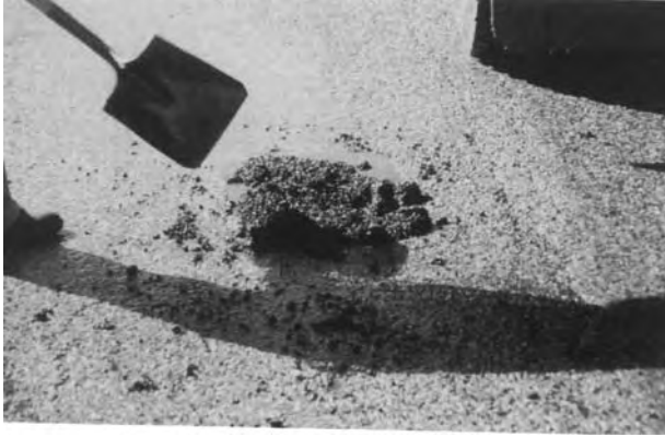
Слика 7.32 Поступак “баци и изваљај” - постављање материјала
