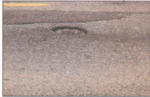
Слика 7.28 Рупа средњег нивоа оштећености
