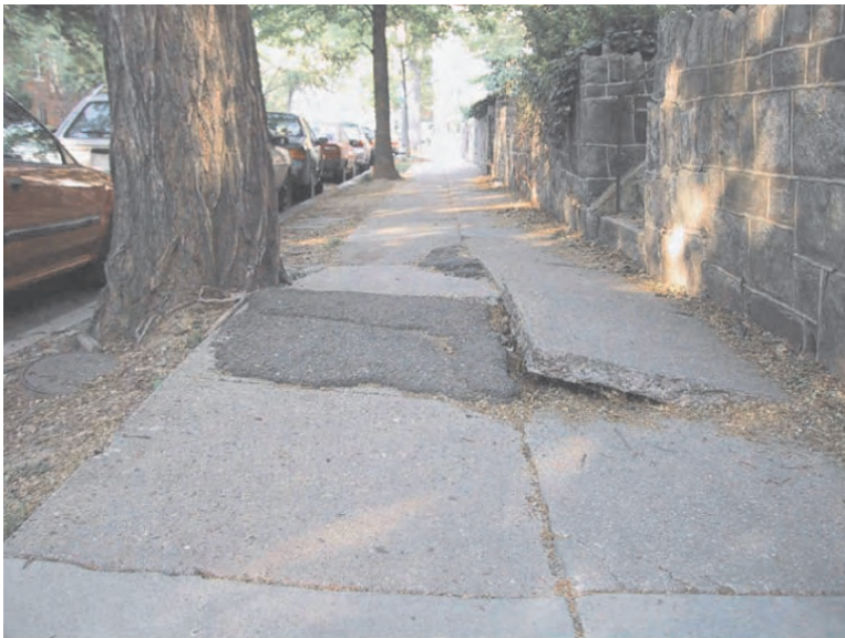
Слика 7.58 Оштећење које није класификовано (резултат деловања корења)
