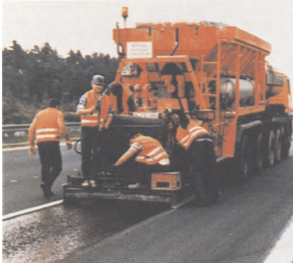
Слика 3.40 Попуњавање колотрага микро-застором
