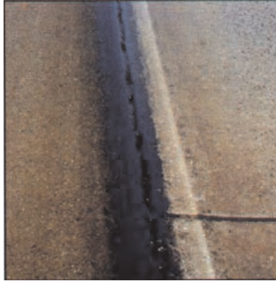
Слика 7.54 Одвајање банке од коловоза
