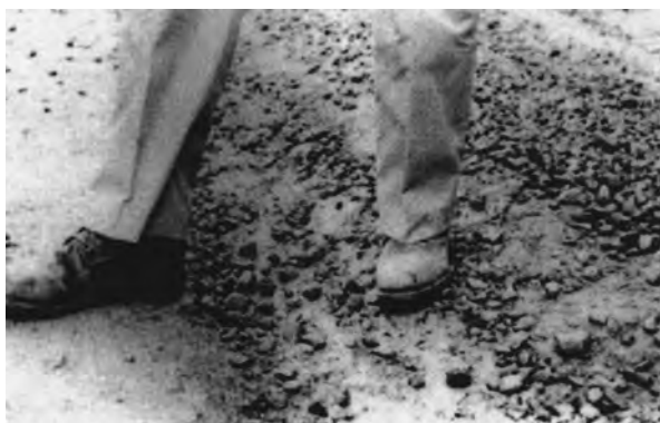
Слика 7.83 Пример ниског нивоа губитка агрегата
