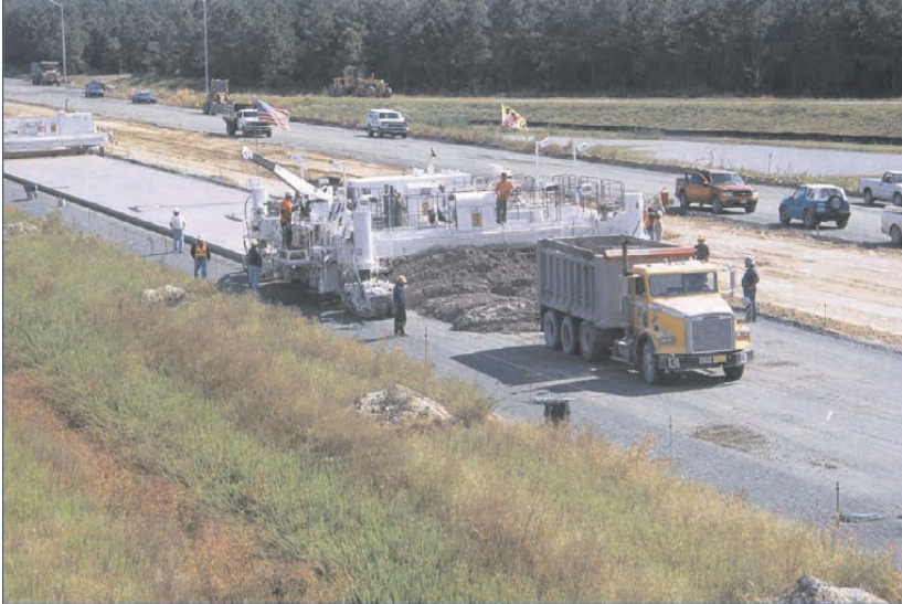
Слика 4.40 Непосредан истовар бетона испред финишера
