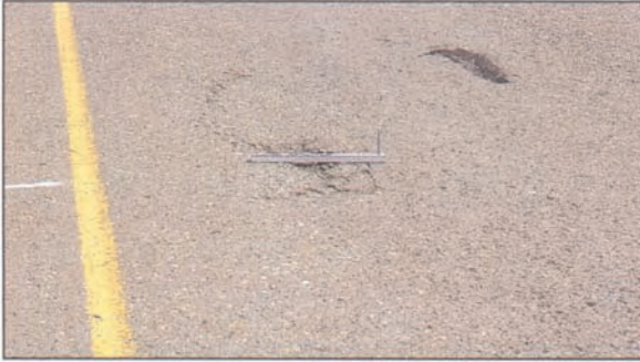
Слика 7.27 Рупа малог нивоа оштећености
