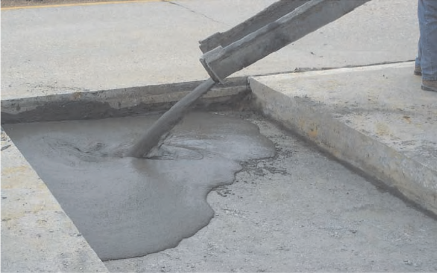
Слика 7.74 Изравнавујући слој
