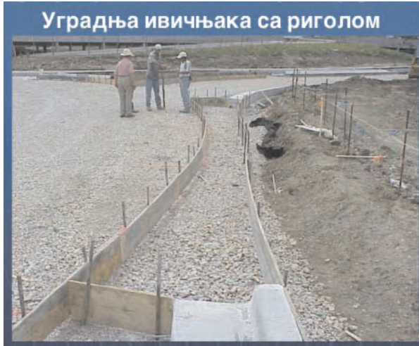
Слика 9.10 Ручна уградња ивичњака са риголом
