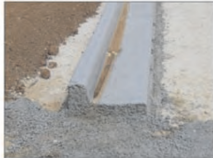
Слика 9.12 Детаљи изливеног ивичњаџа
