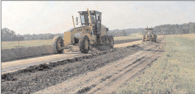
Слика 7.85 Профилисање побољшаног земљаног застора
