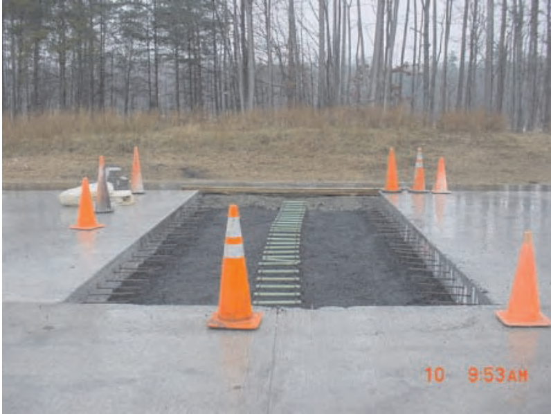
Слика 7.72 Положај елемената за везу - можданика, при замени делова плоча
