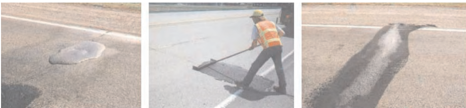
Слика 7.26 Један од могућих начина поправке пукотина (разлачењем масе)
