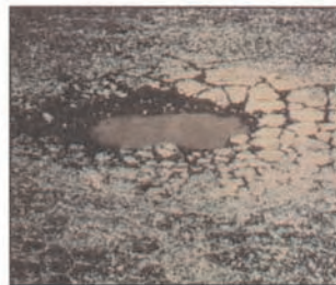
Слика 7.30 Деталј рупе великог нивоа оштећености
