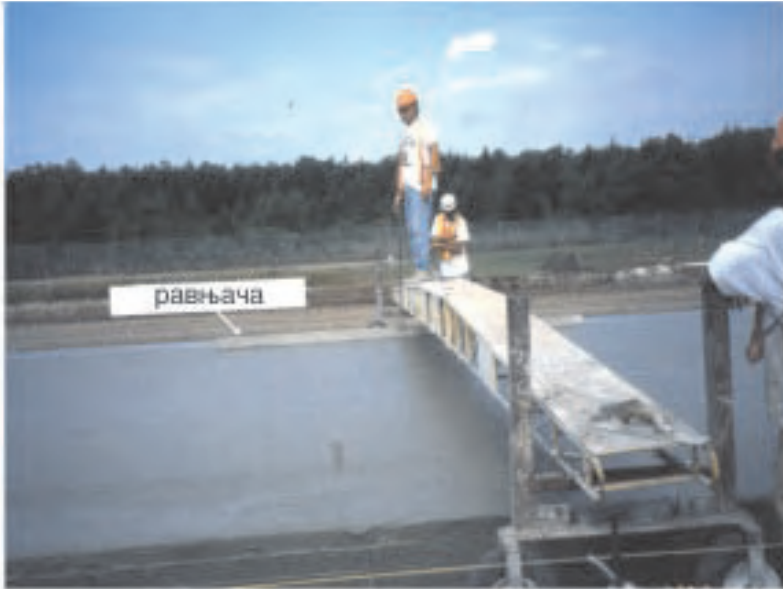
Слика 4.44 Машинско равњање застора од бетона
