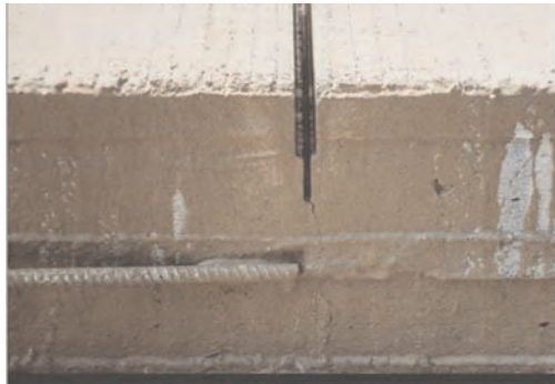
Слика 4.30 Изведена контракциона спојница
