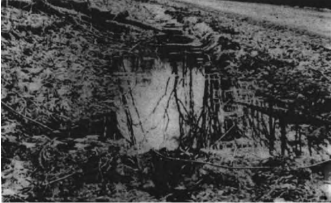
Слика 7.79 Пример неадекватне дренаже високог нивоа оштећености
