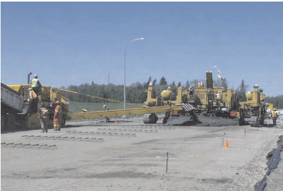
Слика 4.39 Транспорт бетона испред финишера
