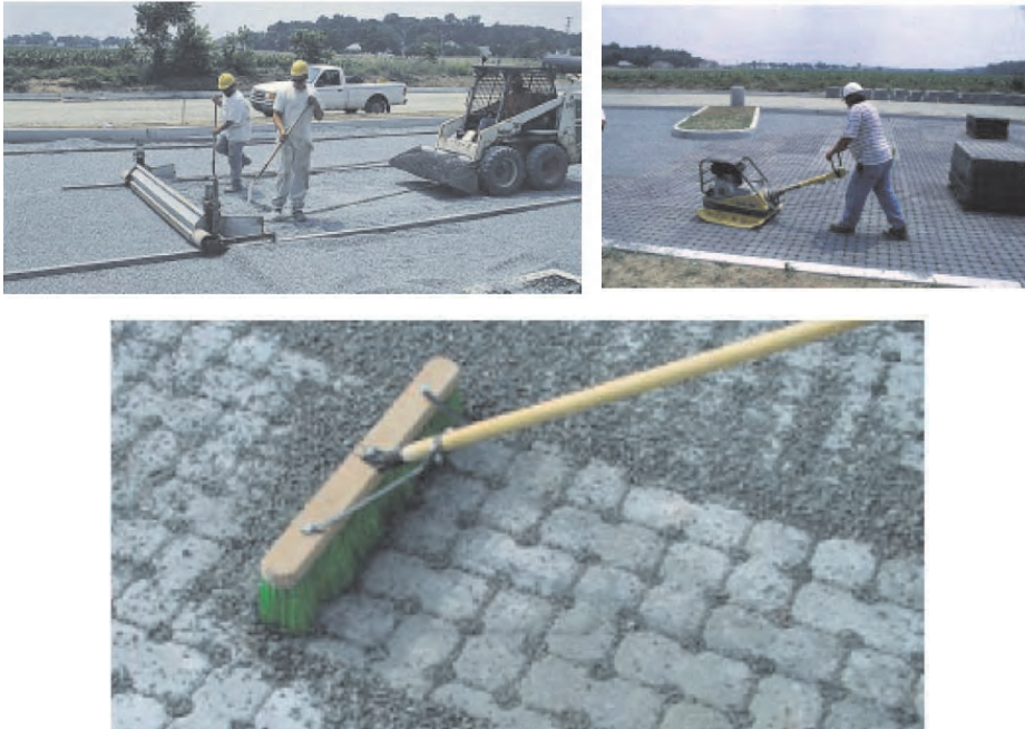
Слика 4.58 Равнање пешчане подлоге, сабијање и испуна спојева
