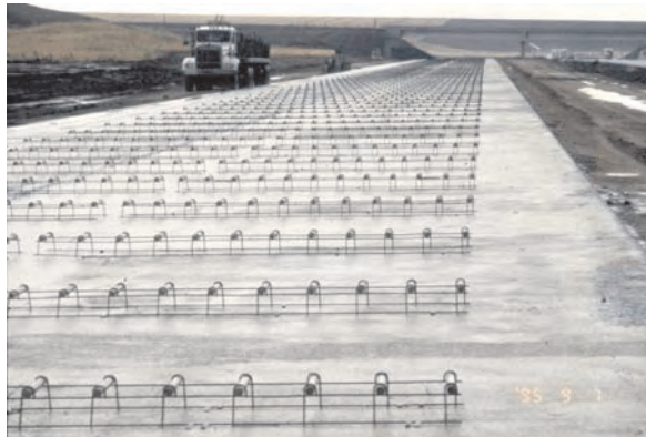
Слика 4.33 Распоред анкера и можданика пре бетонирања
