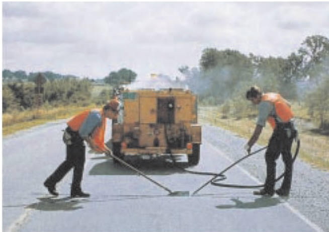
Слика 7.23 Испуна пукотине и уклањање вишка материјала
