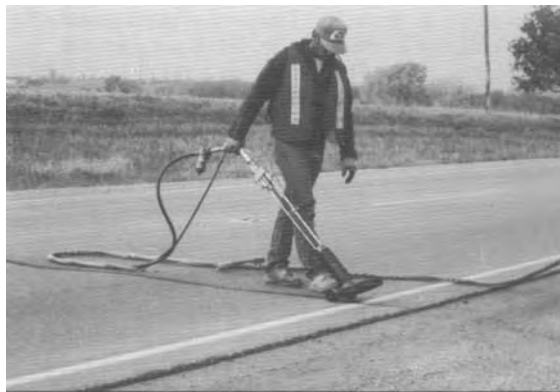
Слика 7.18 Обеспрашивање са заграјаним ваздухом
