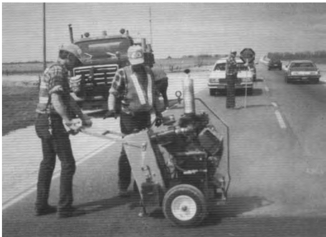
Слика 7.16 Тестера са дијамантским сечивом за пукотине
