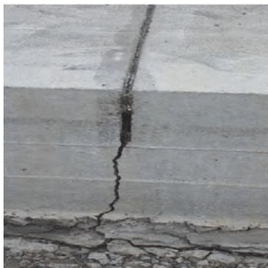
Слика 4.48 На време исечена спојница изазива контролисано пуцање бетона
