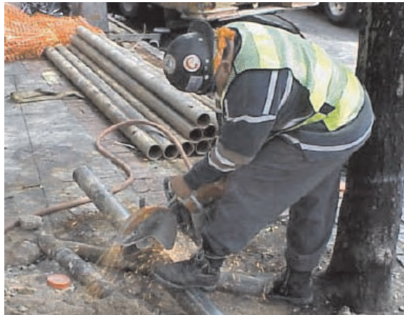
Слика 5.16. Рад на сечењу цеви
