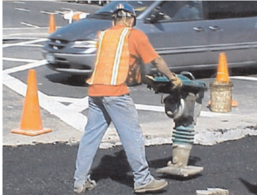
Слика 5.14. Рад са пнеуматским компактором
