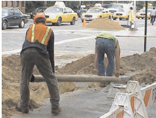
Слика 5.26. Полагање цеви
