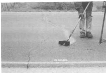
Слика 7.24 Модла у облику "U" за уклањање вишка материјала
