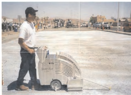
Слика 4.47 Сечење попречних спојница
