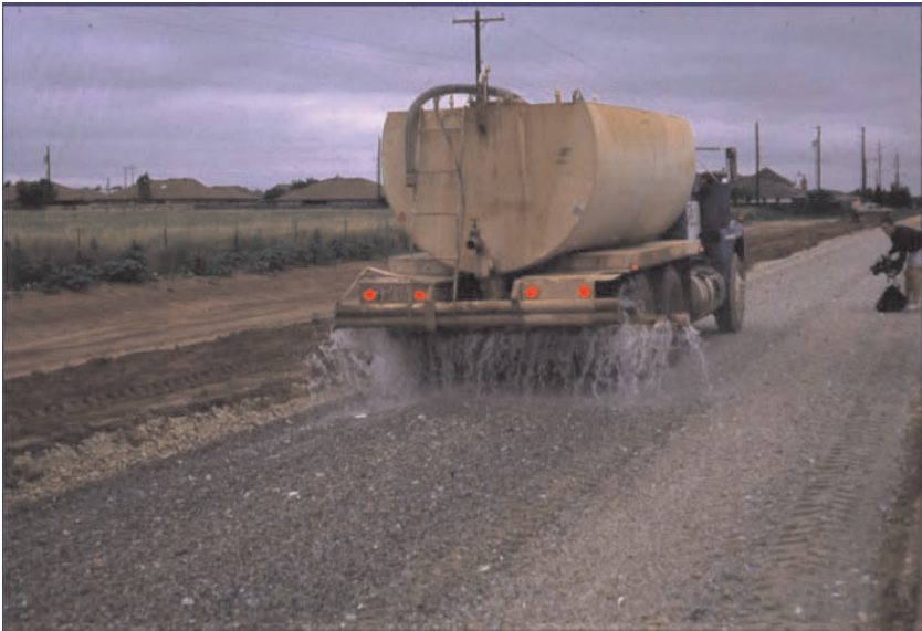
Слика 3.9 Квашење материјала који ће се механички стабилизovati
