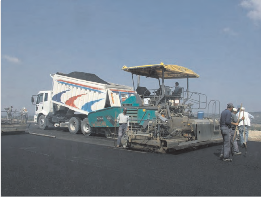
Слика 3.7 Уградња асфалтног бетона
