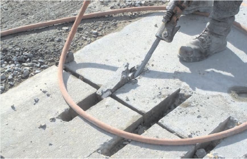
Слика 7.76 Убацавање можданика (да би се везале плоче)
