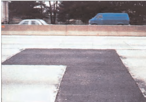
Слика 7.55 Закрпа од асфалта
