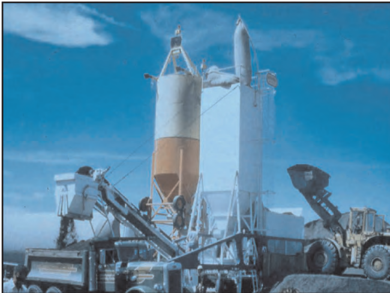
Слика 3.31 Бетонска база
