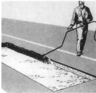
Слика 7.40 Прскање ивица битуменском емулзијом
