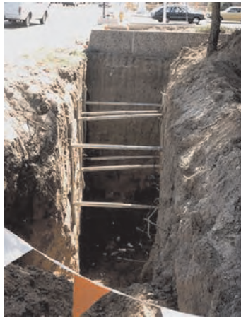
Слика 6.8. Потенцијално обрушавање зидова ископа
