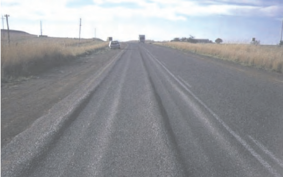
Слика 4.2 Пример недовољне носивости коловозне конструкције
