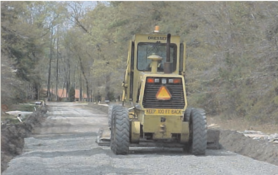
Слика 7.87 Побољшање постојећег земљаног застора
