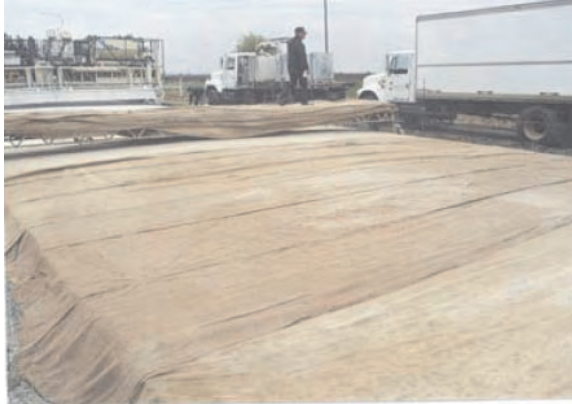
Слика 4.46 Класичан начин неговања бетона
