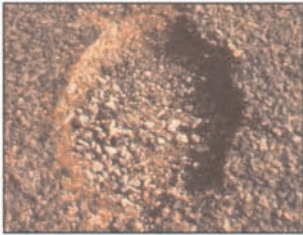
Слика 7.29 Деталј рупе средњег нивоа оштећености
