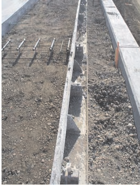
Слика 4.34 Челична оплата (ако се не ради са клизном оплатом)
