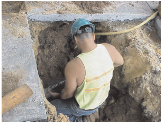
Слика 5.12. Рад са пнеуматским секачем у малом простору
