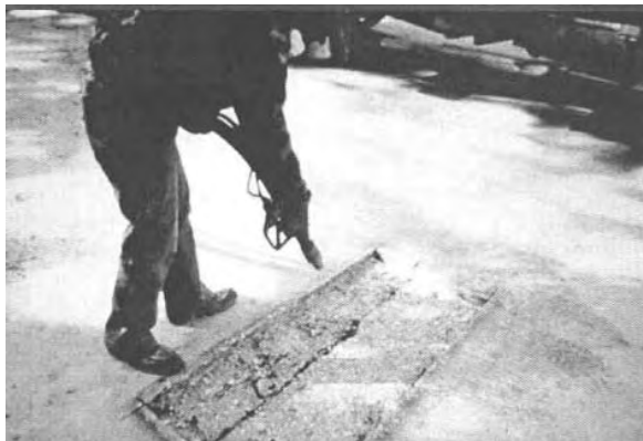
Слика 7.66 Чишћење површине пескарењем
