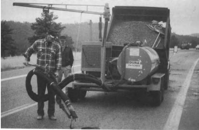
Слика 7.38 Опрема за распршивање - ињектирање (камион са приколицом)
