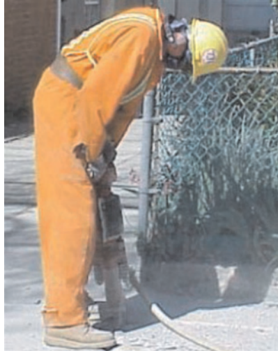
Слика 5.13. Разбијање тротоара
