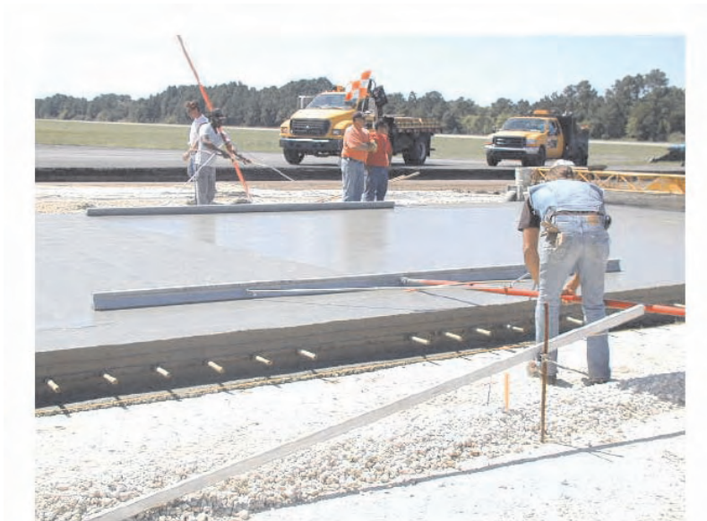
Слика 4.43 Ручно глачање застора од бетона
