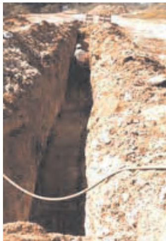
Слика 6.9. Потенцијално обрушавање зидова ископа
