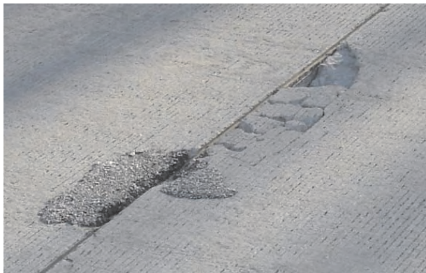
Слика 7.46 Круњење ивица подужних спојница
