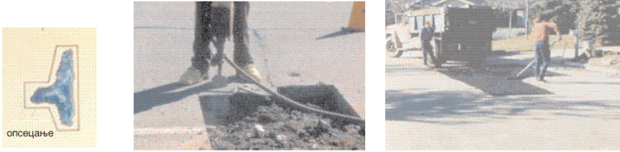
Слика 7.42 Оправка дубоких рупа (наставка предходне слике)
