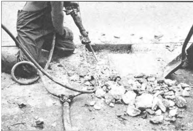
Слика 7.65 Обрада оштећене површине
