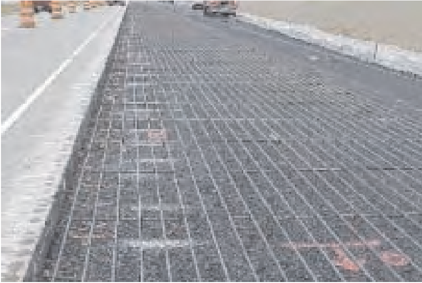
Слика 4.36 Положена арматура за израду армираног бетонског коловоза
