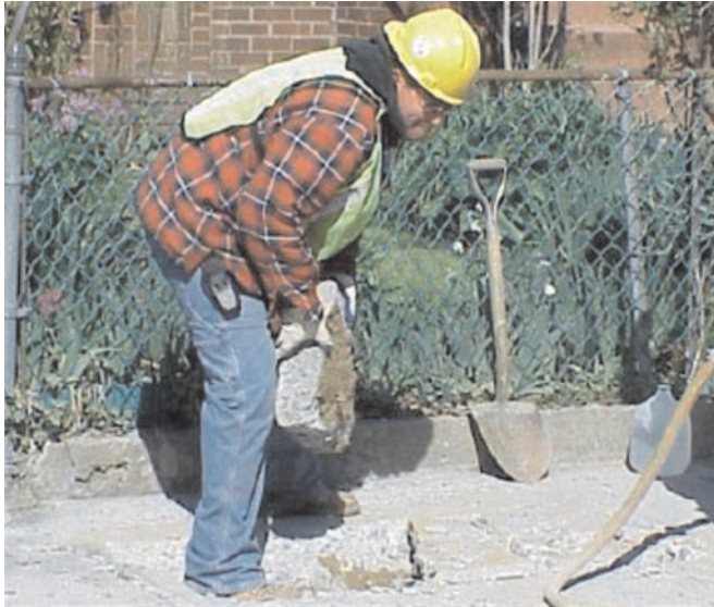
Слика 5.21. Ручни рад са изломљеним ковадима коловозне конструкције
