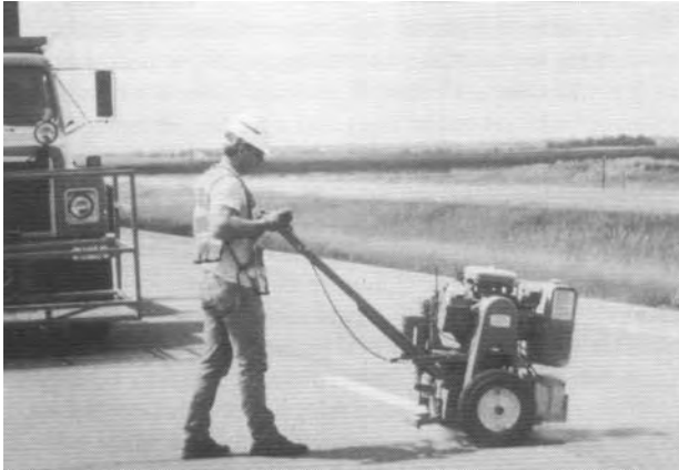
Слика 7.15 Ротациона ударна глодалица
