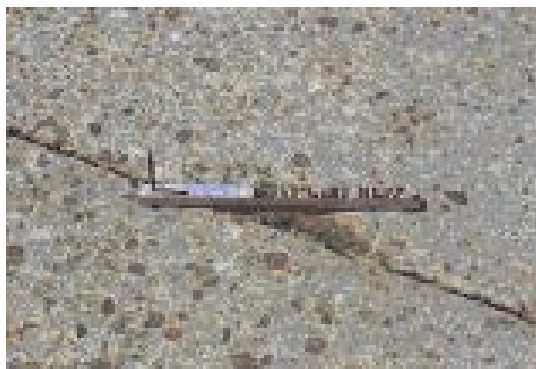
Слика 7.47 Круњење ивица попречних спојница
