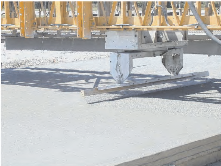
Слика 4.45 Храпављење свежег бетонског застора
