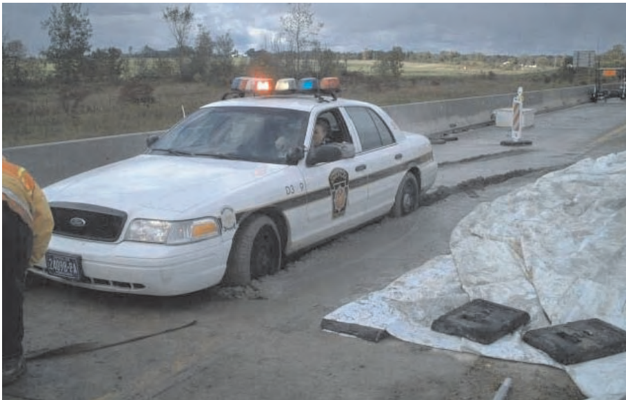
Слика 3.34 Непоштовање времена неговања бетона
