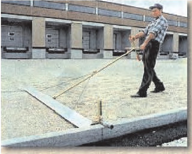
Слика 4.56 Ручно равнање подлоге за полагање бетонских елемената
