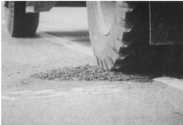
Слика 7.33 Поступак “баци и изваљај” - збијање закрпе
