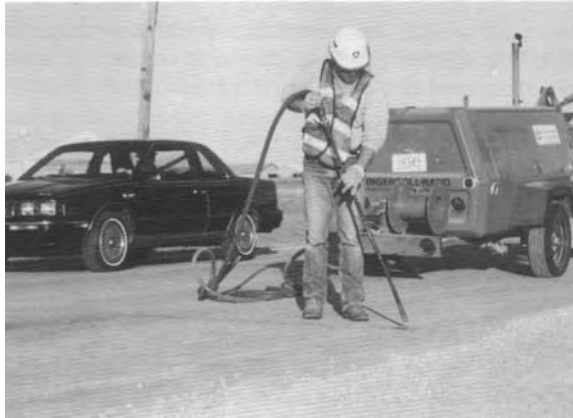
Слика 7.17 Обеспрашивање са компресором
