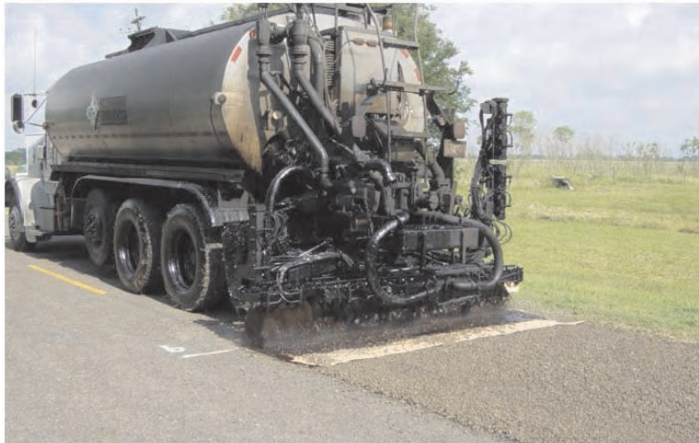
Слика 3.19 Почетак и крај обраде споја старог и новог застора
