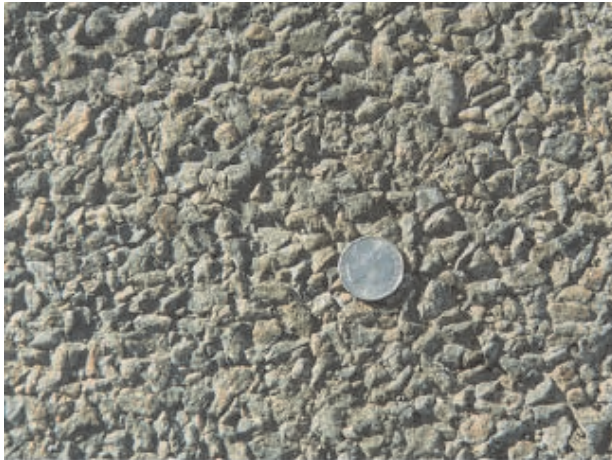
Слика 3.12 Изглед застора од површинске обраде
