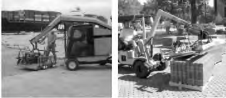
Слика 4.67 Механизовано полагање елемената
