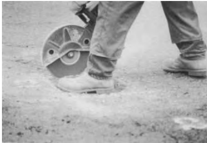
Слика 7.34 Полу - стални поступак (опсецање ивица рупе ручном тестером)
