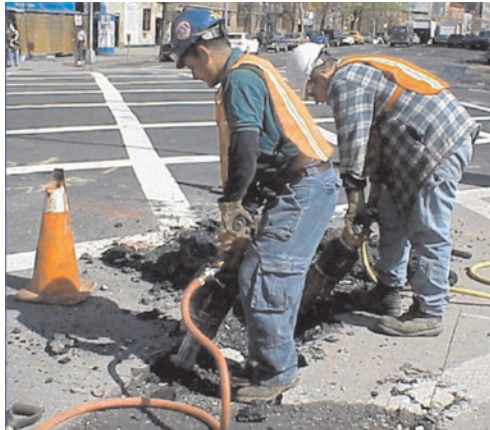
Слика 5.11. Рад са пнеуматским секачима на разбијању коловозне конструкције
