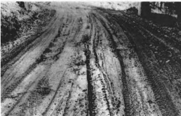
Слика 7.78 Пример попречног профила високог нивоа оштећености
