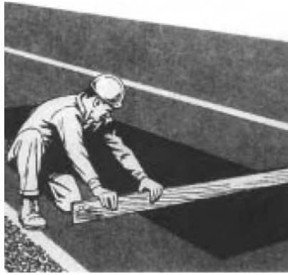
Слика 7.43 Контрола равности извршене закрпе
