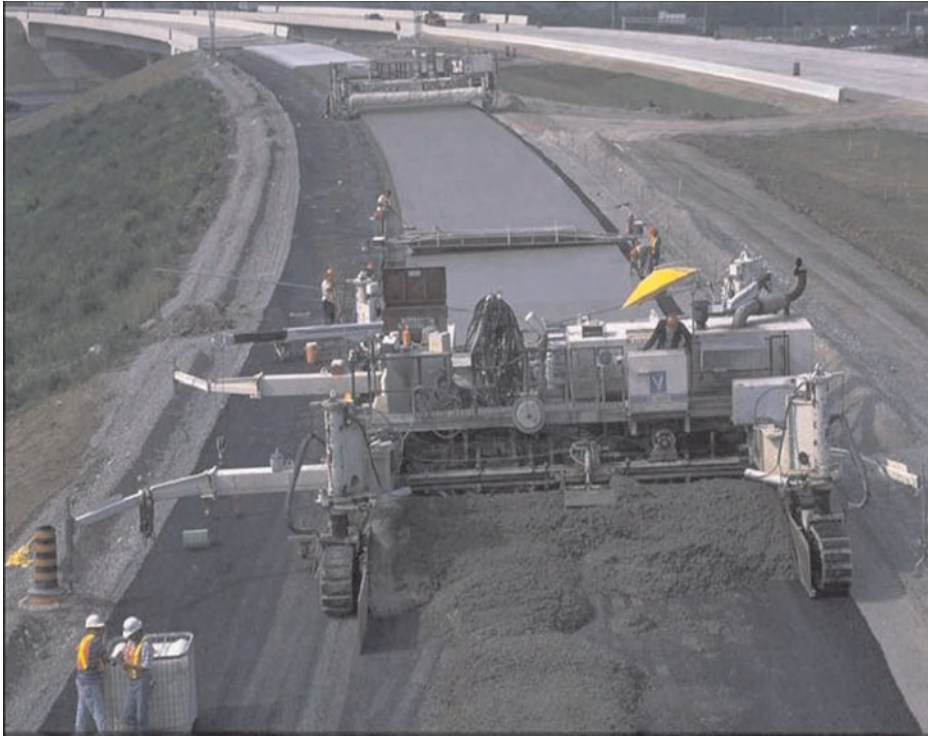
Слика 3.8 Уградња бетона
