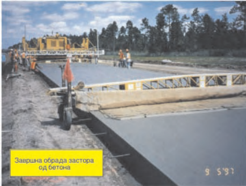
Слика 4.42 Глачање бетонског застора
