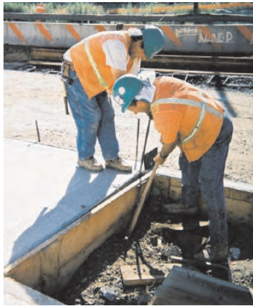
Слика 5.33. Скидање оплате
