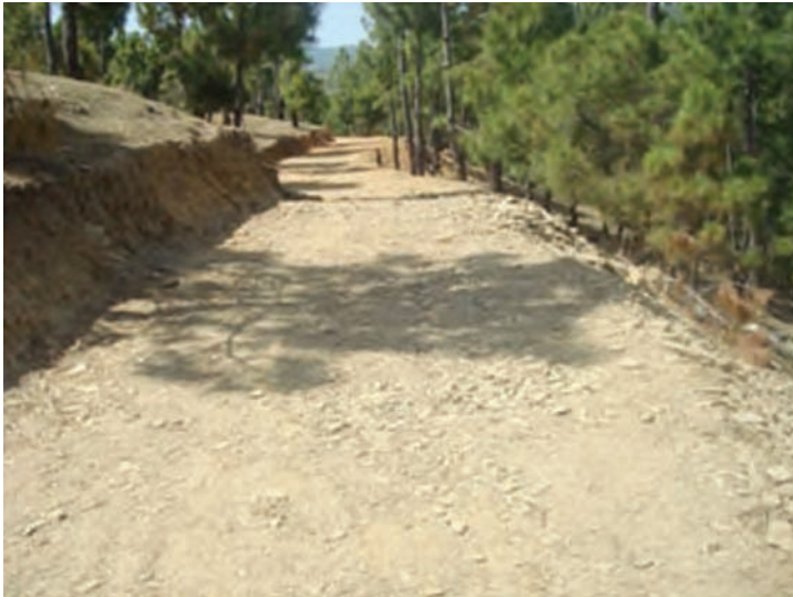
Слика 6.4. – Изградња локалног пута
