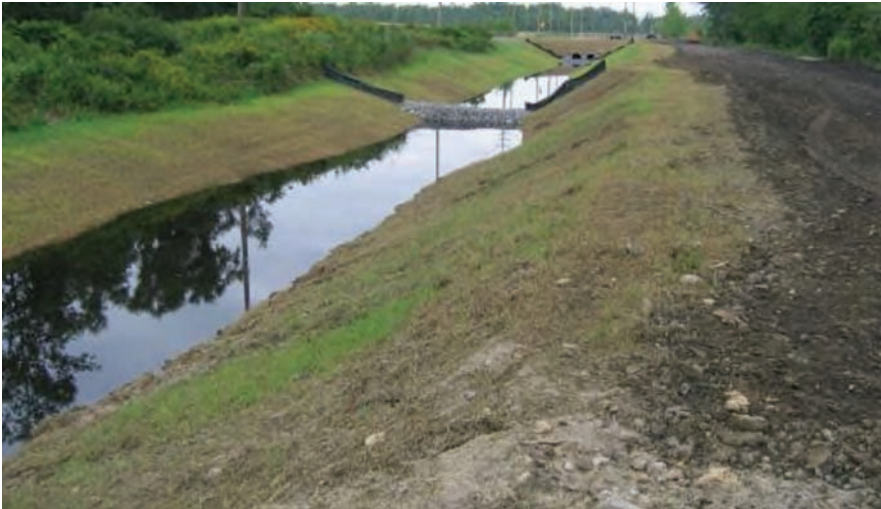
Слика 6.2. – Одводњавање локалног пута
