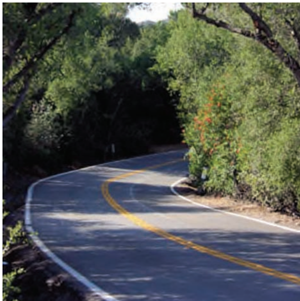
Слика 6.5. – Изграђен локални пут
