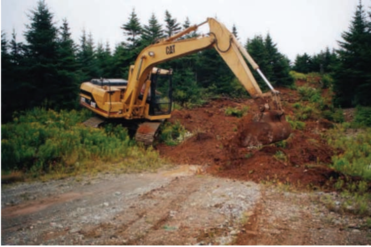
Слика 6.3. – Изградња локалног пута
