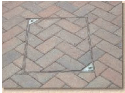
Слика 4.15 – Изглед готовог поклопца шахта у застору од префабрикованих бетонских елемената
